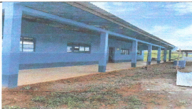
Foto 3: se logra apreciar el cambio que ha sufrido el corredor del establecimiento.
